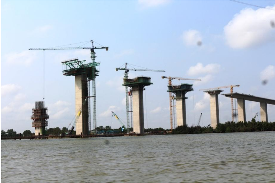
Cầu vượt nối liền hai bờ sông Lòng Tàu (nơi diễn ra nhiều trận đánh từ căn cứ Rừng Sác) thuộc dự án tuyến cao tốc Bến Lức – Long Thành đang được triển khai [Nguồn: Nguyễn Thị Phượng]
