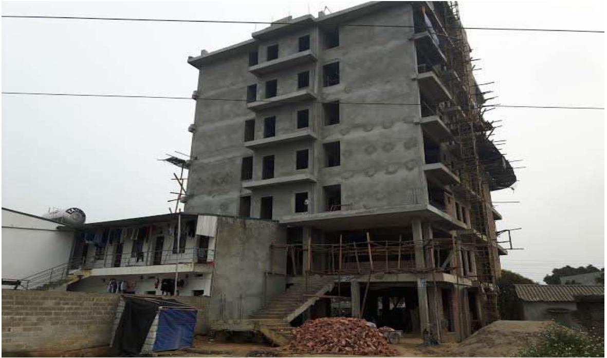
Hình 2.8: Công trình 8 tầng của Công ty TNHH Đồ gỗ - Nội thất Xuân Tiến vẫn tiếp tục tồn tại, khi chưa có giấy phép xây dựng cũng như giấy chứng nhận QSDĐ. (Nguồn: Sưu tầm)
