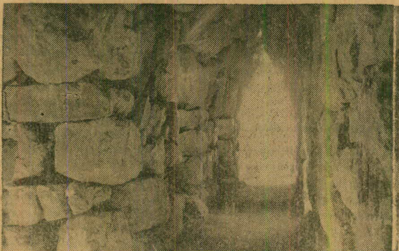
HÌNH 3— Một « hăng » của Thành Tyrin, do dân tộc Mycén xưa cất cách đây cỡ 3600 năm. Kiến trúc vô cùng đồ sộ, mỗi đá nặng cả chục tấn (lỗi viên nặng trên 100 tấn)
