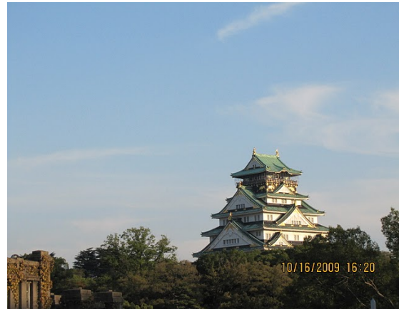
Tháp chính của thành Osaka được xây dựng lại năm 1931
