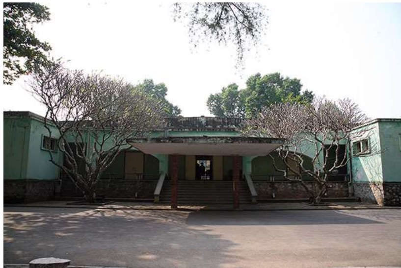
Phụ lục 2.9: Nhà và hầm D67 (Nguồn: Nguyễn Thị Anh Đào)
